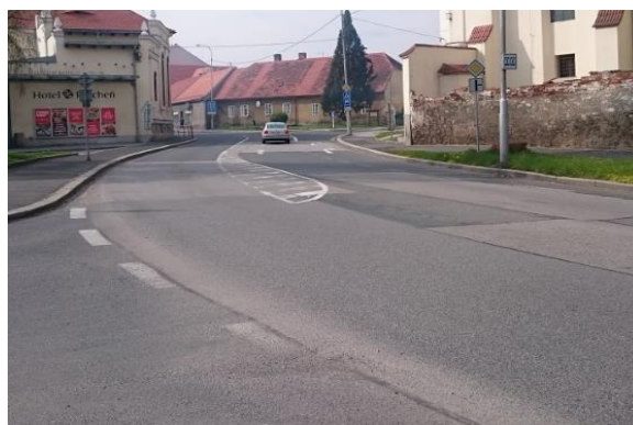
Obr. 59: Opotřebeně VDZ v křiž. u Husova nám.
