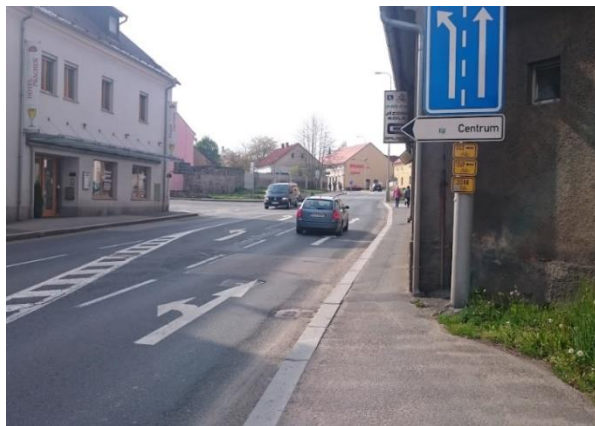
Obr. 26: Příklad nevhodného příčného uspořádání bez prvků pro cyklisty u hotelu Prácheň
