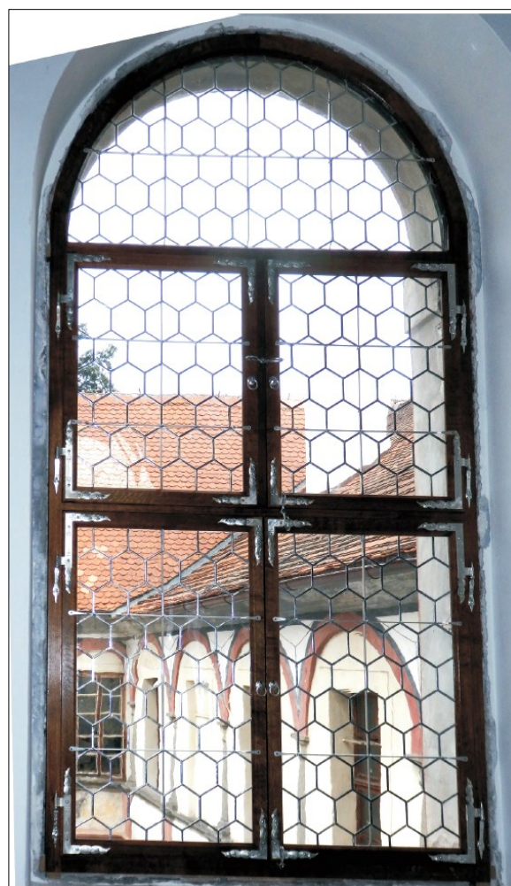
Stav po restaurování - celkový pohled na okno z interiéru kaple po osazení, před zamalováním obvodového rámu.
