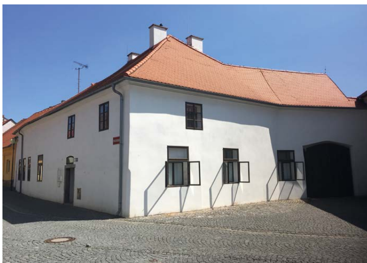
Současný stav objektu (r. 2017)
