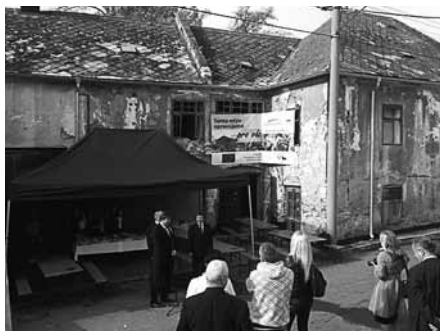
Slavnostní zahájení rekonstrukce
