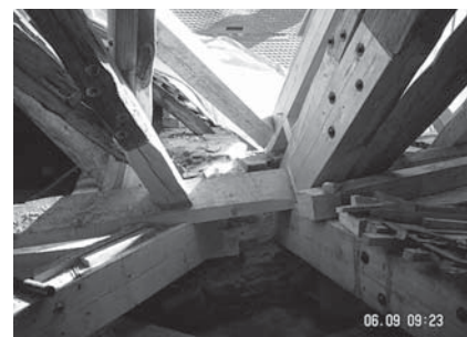
Krov po obnově
