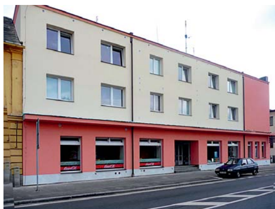
Zateplení objektu, Strakonická ulice
