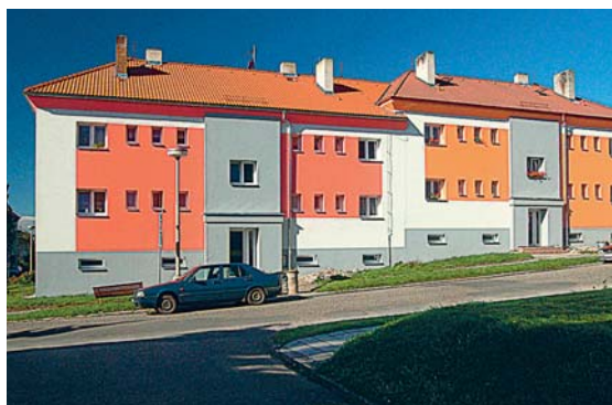
Blatenská ulice, zateplování
