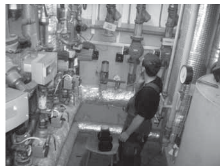
Na fotce z kotelny je pracovník firmy Stavoplast KL ze Stach, která vyhrála výběrové řízení na výměnu čerpadel, při montáži.
