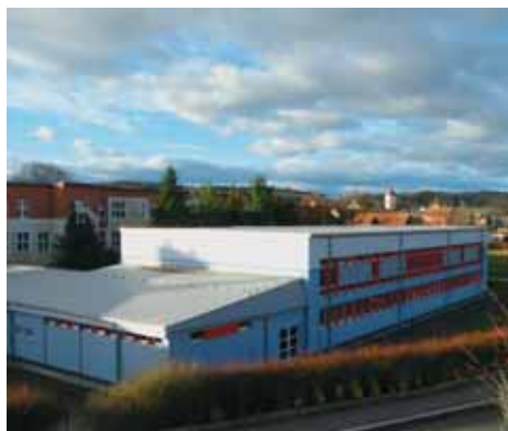
Dokončení zateplení tělocvičny ZŠ Blatenská, foto: J. Presl
