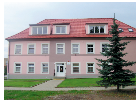
ZŠ a MŠ Střelské Hoštice – rekonstruovaná budova
