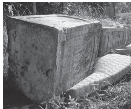
Detailní pohled na čerstvě sejmuté těleso kříže.
