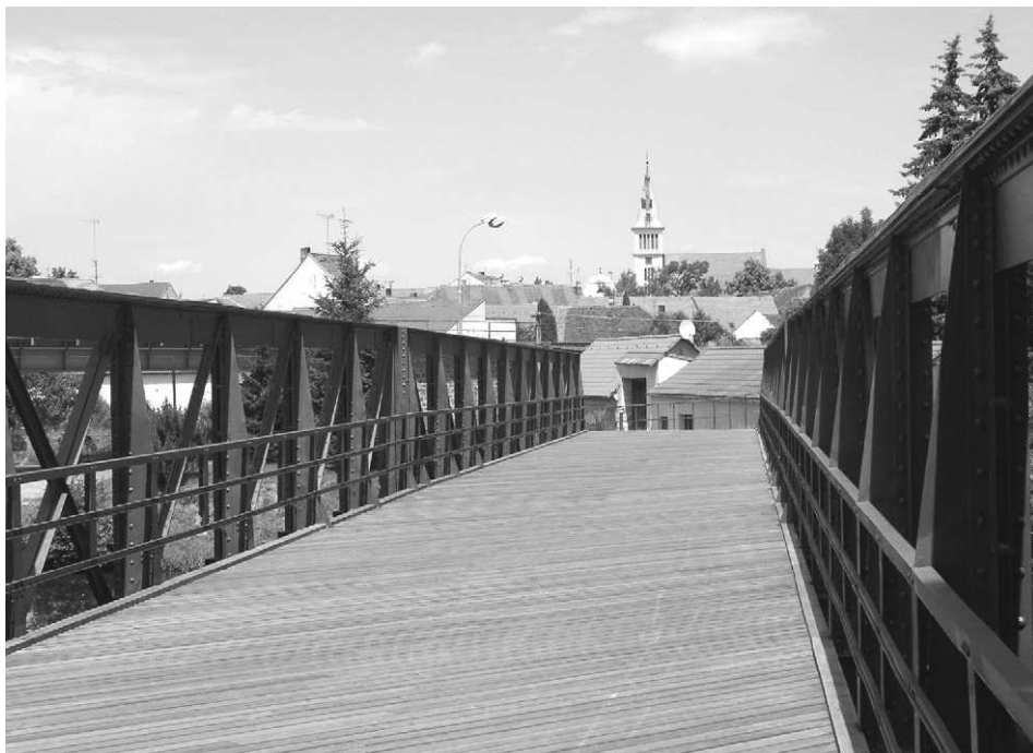
Město zdobí nově opravený ocelový přehradový most přes Otavu pocházející z r. 1909.
