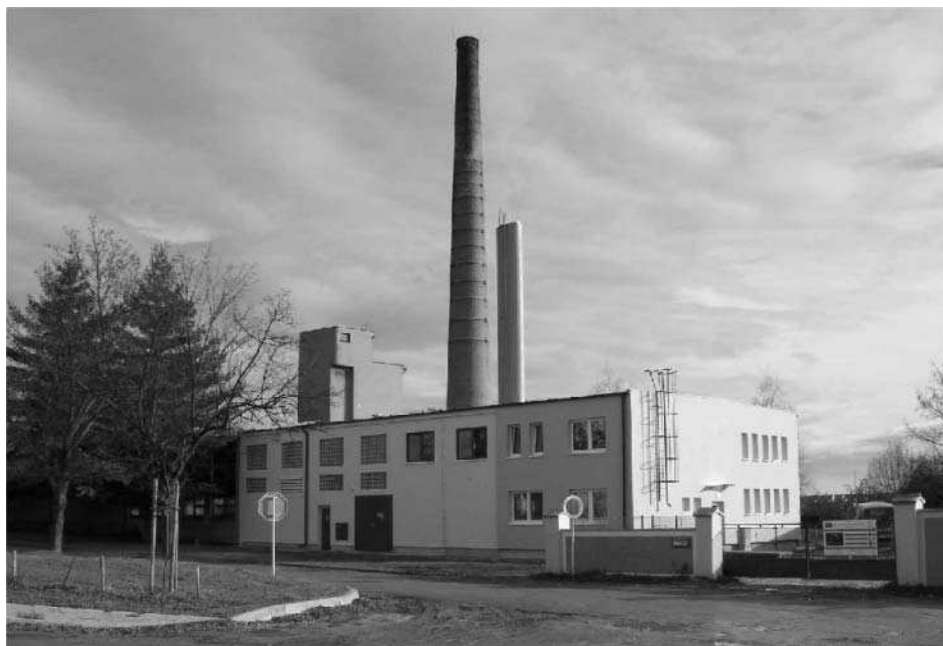
Nově zrekonstruovaná plynová kotelna v Okružní ulici.
