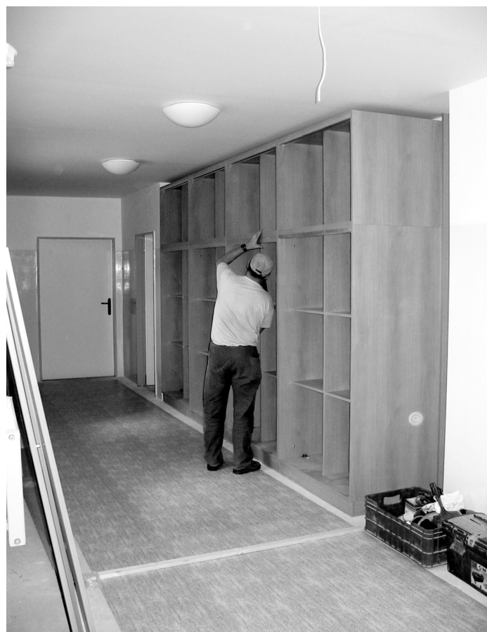
Závěrečné práce na interiéru v SV přístavbě
