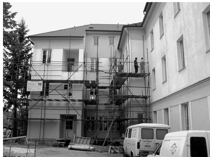
Odstraňování lešení ze SV přístavby
